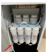
13. Gắn thêm 1 đoạn ống nhựa PE vào để cho nước chảy ra ngoài, rồi mở van cấp nước và cắm điện nguồn. Hãy để nước chảy ra liên tục khoảng 10 phút để xả bộ lọc.
