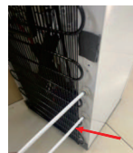
24. Lắp ống PE cấp nước vào lại máy như ban đầu (đã tháo ra từ bước 18).
