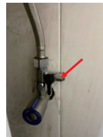
4. Lắp van cấp nước vào đường ống nước máy.
