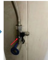
5. Lắp van cấp nước vào đường ống nước máy. Lực mô men xoắn của đai ốc là khoảng 3,2N/m.
