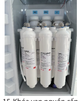
15. Khóa van nguồn cấp nước và tắt nguồn điện.
