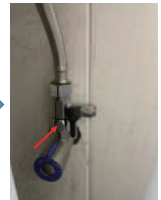
5. Lắp van cấp nước vào đường ống nước máy. Lực mở men xoắn của đai ốc là khoảng 3,2N/m.
