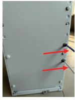
8. Lắp ống nhựa PE từ van cấp nước đến ống vào nước trên máy, rồi lắp thêm ống cho ống xả nước.
