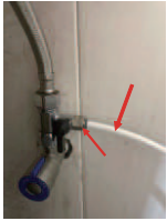
6. Nối ống nhựa PE với bộ van cấp nước. Siết chặt để đai ốc không bị xoay.
