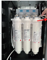
23. Tháo hai ống nhựa PE trong bước 20 và 21 ra.
