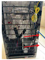
8. Lắp ống nhựa PE từ van cấp nước đến ngò vào nước trên máy, rồi lắp thêm ống cho ngò xả nước.
