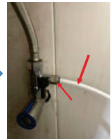
5. Nối ống nhựa PE với van cấp nước đầu vào. Siết chặt để đai ốc không bị xoay.
