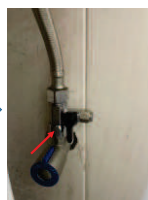
4. Nối van cấp nước đầu vào với ống dẫn nước máy. Lực mô men xoắn của đai ốc là khoảng 3,2N/m.
