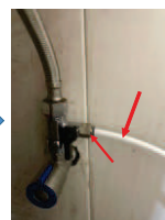
5. Nối ống nhựa PE với van cấp nước đầu vào. Siết chặt để đai ốc không bị xoay.
