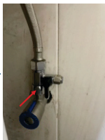
3. Nối van cấp nước đầu vào với ống dẫn nước máy. Lực mô-men xoắn lắp của đai ốc là khoảng 3.2N/m.
