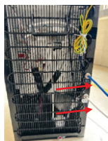
6. Lắp ống nhựa PE vào ngõ vào nước máy và ngõ ra nước xả.
