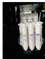
22. Lắp lại hai ống nhựa PE ban đầu. Gắn đầu nối nhanh vào bộ lọc Tourmaline-T33 và bộ lọc Nano Bạc-T33.
