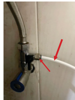
4. Nối ống nhựa PE với van cấp nước đầu vào. Siết chặt đai ốc cho đến khi không bị xoay.
