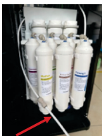
12. Nối ống nhựa PE và bật nguồn nước và nguồn điện. Xả sạch bộ lọc trong khoảng 10 phút.
