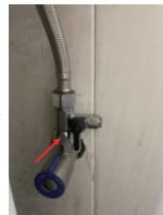
4. Gắn van bi đầu vào vào đường ống nước máy. Lực mô-men xoắn lắp của đai ốc là khoảng 3.2N/m.
