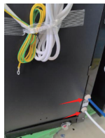
7. Lắp ống PE vào van cấp nước và van xả nước.
