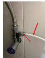
5. Gắn ống PE vào van bi đầu vào. Siết chặt đai ốc cho đến khi siết chặt.
