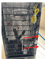
8. Lắp ống PE vào van cấp nước và van xả nước.
