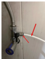
6. Gắn ống PE vào van bi đầu vào. Siết chặt đai ốc cho đến khi siết chặt.
