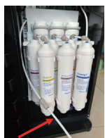
14. Nối ống PE và bật nguồn nước và nguồn điện. Xả sạch bộ lọc trong khoảng 10 phút.
