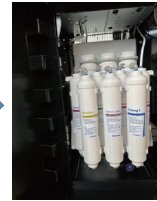
24. Lắp hai ống PE ban đầu. Gắn đầu nối nhanh vào bộ lọc Tourmaline-T33 và bộ lọc Nano Silver-T33.
