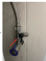
5. Gắn van bi đầu vào vào đường ống nước máy. Lực mô-men xoắn lắp của đai ốc là khoảng 3.2N/m.
