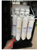
20. Gắn ống PE từ bước cuối cùng vào đầu vào của bộ lọc Tourmaline.
