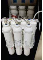
14. Nối dài ống nhựa PE vừa lắp (nếu cần), sau đó mở nguồn nước và điện. Hãy để nước chảy ra liên tục khoảng 15 phút.
