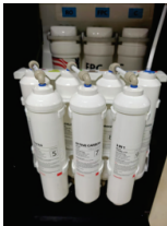
16. Lắp ống nhựa PE ban đầu vào bộ lọc nano bạc-T33 và lắp vòng khóa lại. Sau khi lắp đặt, mở van cấp nước và cắm phích điện nguồn sau đó sử dụng bình thường.
