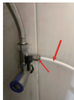
5. Gắn ống nhựa PE vào van cấp nước vào. Siết chặt đai ốc cho đến khi không bị xoay.
