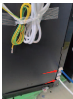
7. Lắp ống nhựa PE vào ngò vào nước máy và ngò ra nước xả.
