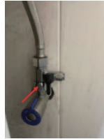
4. Gắn van cấp nước vào đường ống nước máy. Lực mô-men xoắn lắp của đai ốc là khoảng 3.2N/m.
