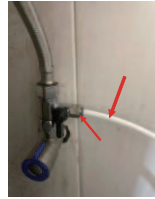
5. Gắn ống nhựa PE vào van cấp nước vào. Siết chặt đai ốc cho đến khi không bị xoay.
