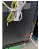
7. Lắp ống nhựa PE vào ngò vào nước máy và ngò ra nước xả.
