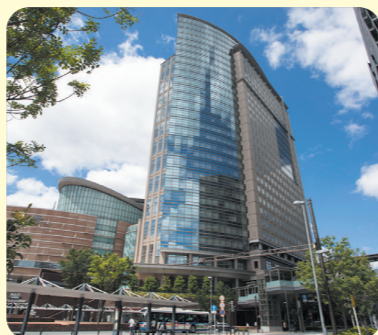
本社(ミューザ川崎セントラルタワー-9・10・11階)
